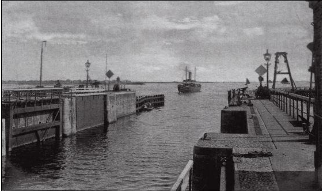
De in 1872 gereedgekomen Oranjesluizen in het Amsterdamse IJ
